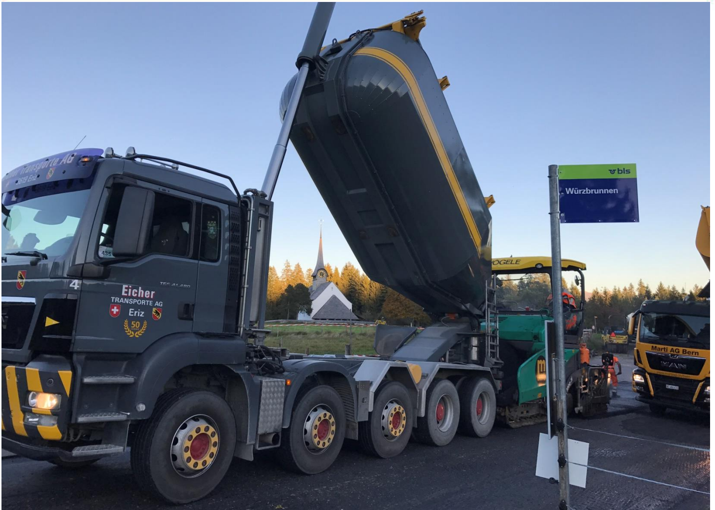
Sanierung Strasse Röthenbach-Chuderhüsi
