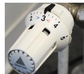
Thermostatventil zur Regelung der Raumtemperatur
