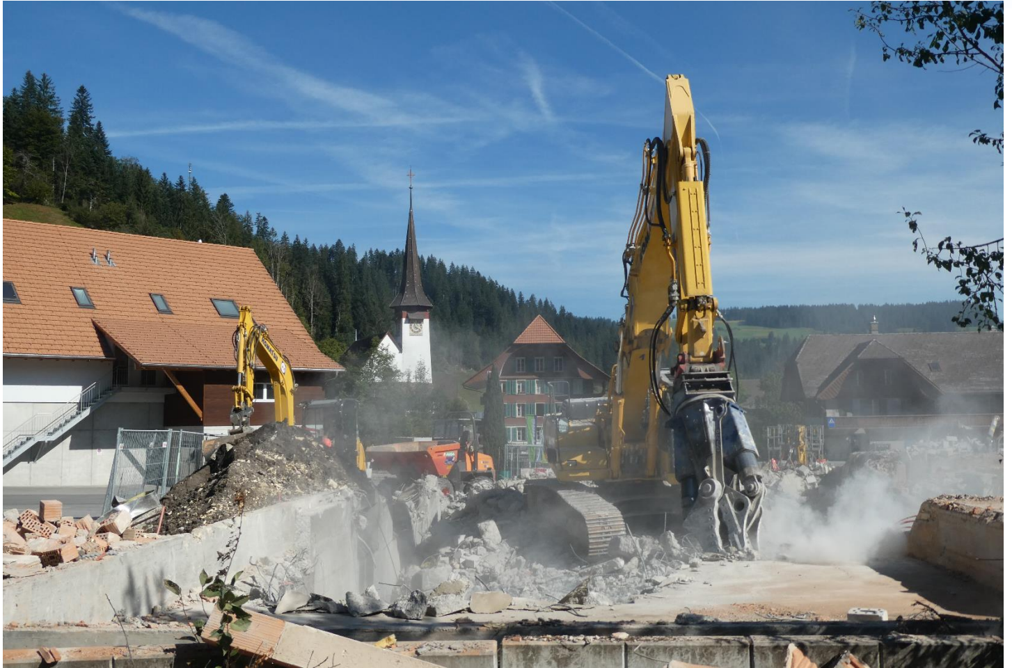
Rückbau der alten Landi
