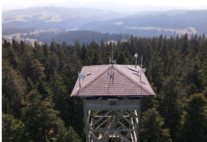
Neue Funkanlage der BKW (Foto: Benjamin Mosimann)
